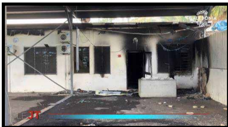
Païta, 25 juin. Incendie du bâtiment du « Détachement spécial d'intervention » de la gendarmerie (DSI)
