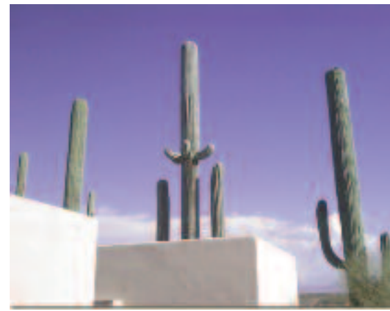
Antenne relais de téléphone mobile «totale-ment» déguisée
