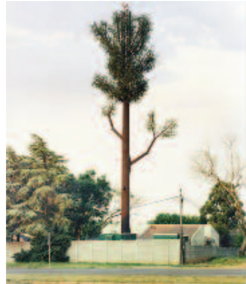
Antenne relais de téléphone mobile subtilement déguisée
