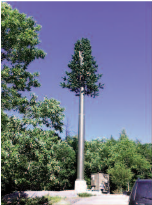
Antenne relais de téléphone mobile partiellement déguisée
